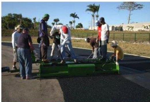
Aplicación de Capa Elástica.
