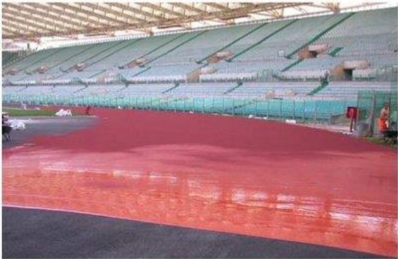
Aplicación de Capa de Poliuretano autonivelante.
